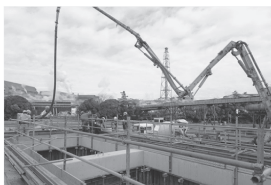
図 16 実施工におけるコンクリート打設 Fig. 16 The placement of concrete in actual work
